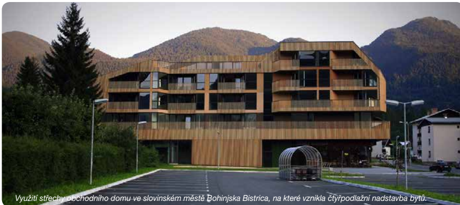
Využití střechy obchodního domu ve slovinském městě Bohinjka Bistrica, na které vznikla čtyřpodlažní nadstavba bytů.
